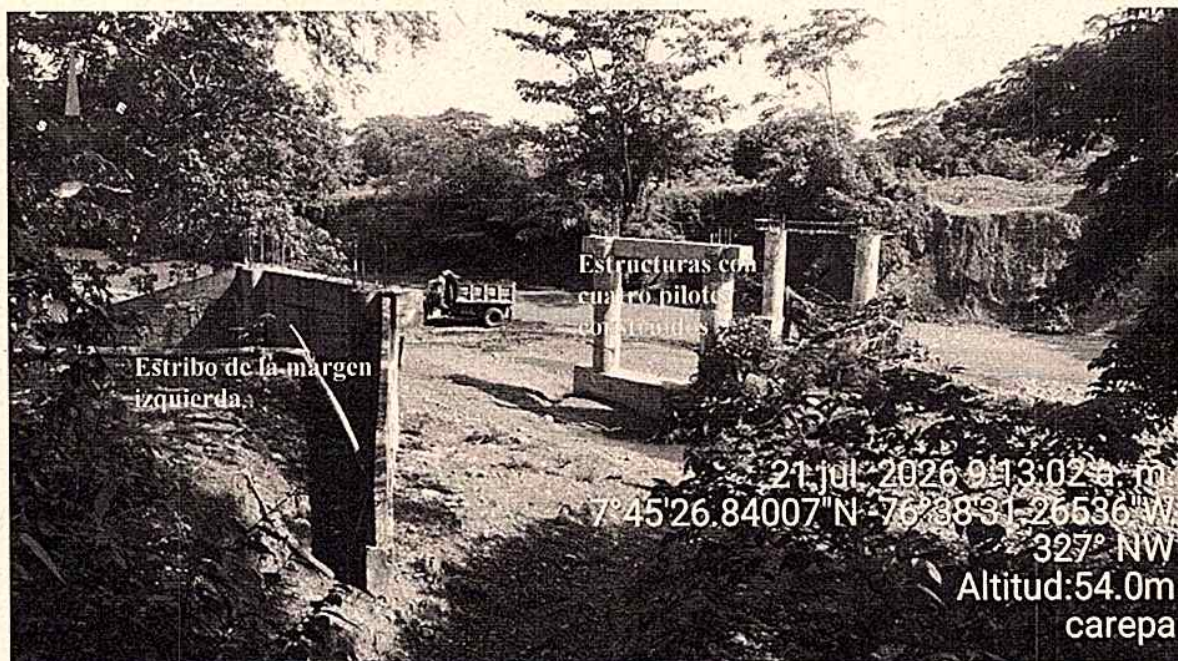
Foto 1: Estribo de la margen izquierda y dos estructuras con dos pilotes construidos sobre el cauce del río Carepa sin el debido permiso por parte de CORPOURABA.
