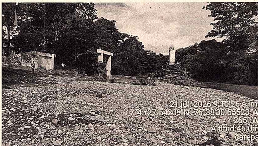
Foto 2: Estructuras con cuatro pilotes sobre el cauce del río Carepa a la altura del barrio La Cadena y estribo de la margen izquierda.
