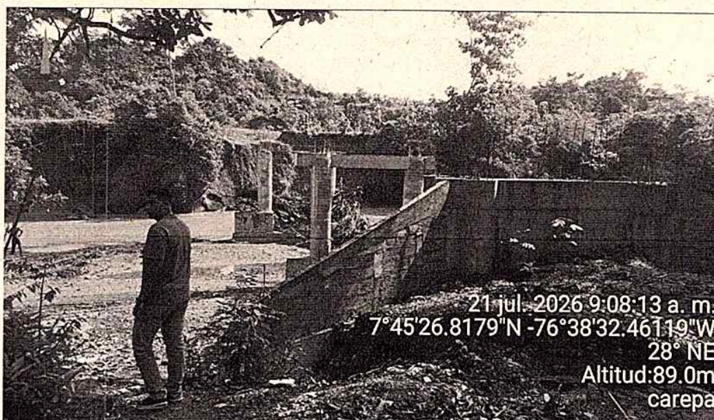
Foto 3: Estribo de la margen izquierda y dos estructuras con dos pilotes construidos sobre el cauce del río Carepa.
