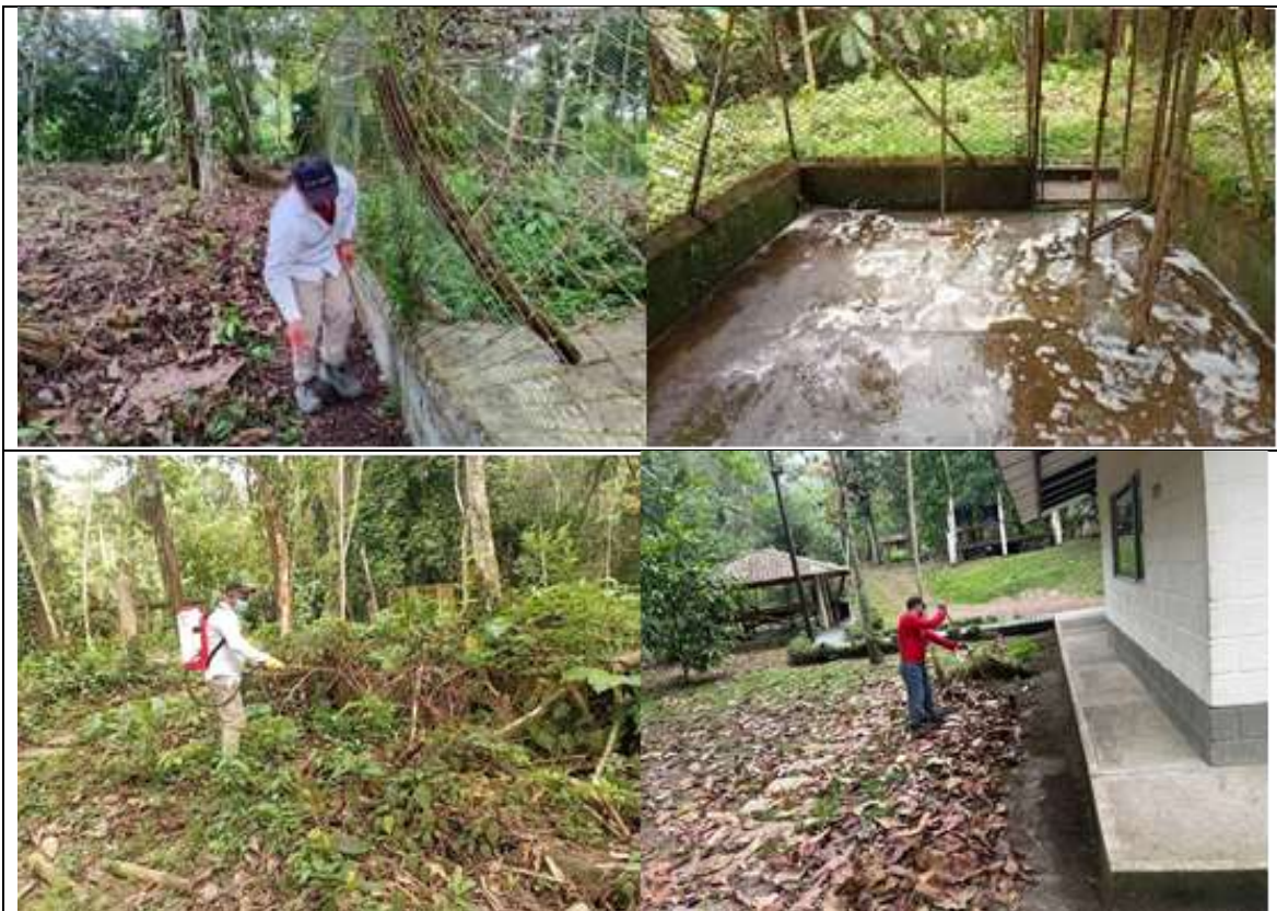
Registro fotográfico: Mantenimiento Senderos peatonales, Escaleras peatonales, Reparación de jaulas
