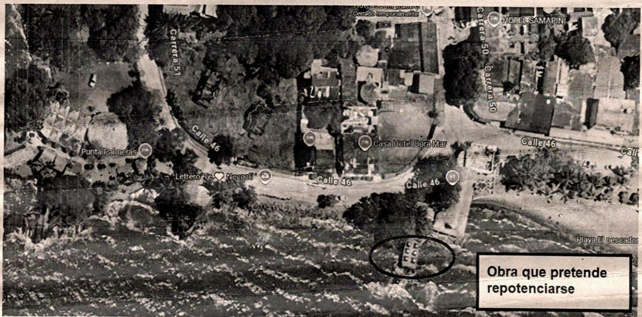
Figura 3. Estructura en construcción sobre la obra.
