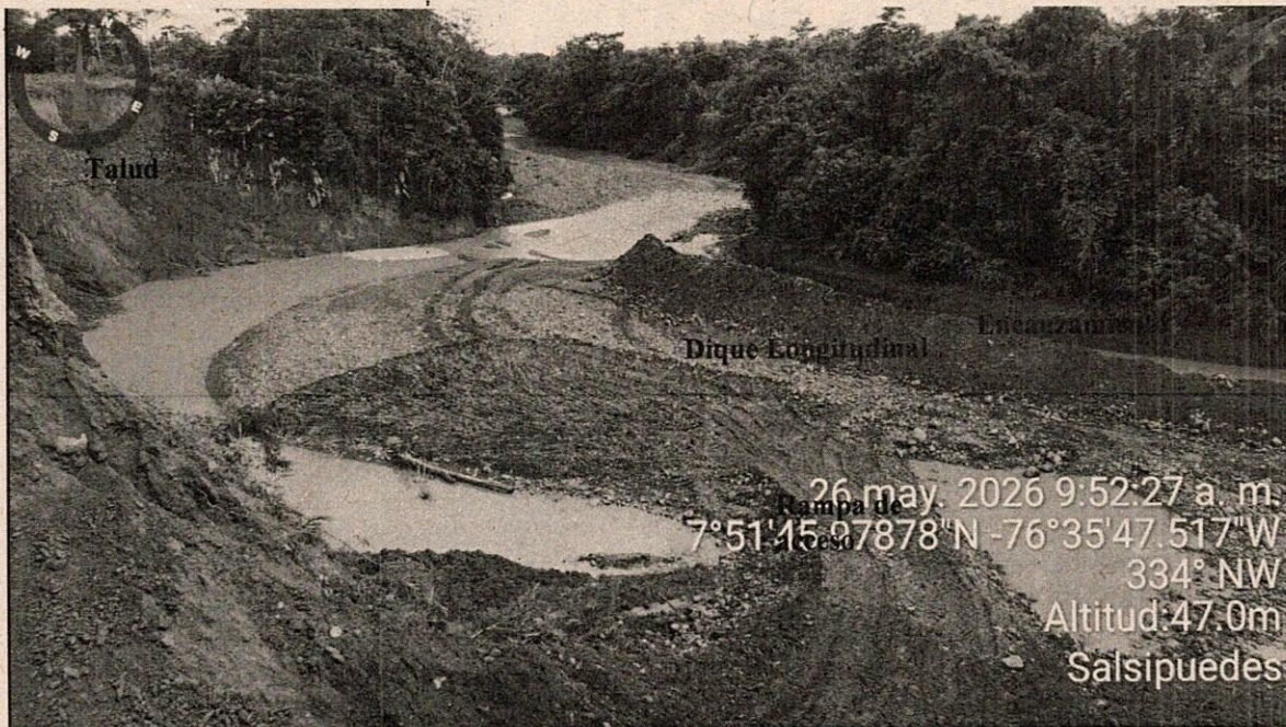
Foto 1: Se observa el dique longitudinal con material aluvial y el canal de encauzamiento. También la rampa de acceso al cauce y el talud de la margen izquierda del río Apartadó.
