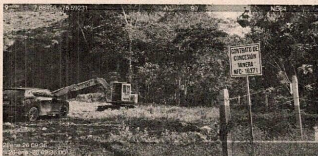
Figura 16. Entrada al frente La Balsa del Contrato de Concesión Minera N° NFC-16371.
