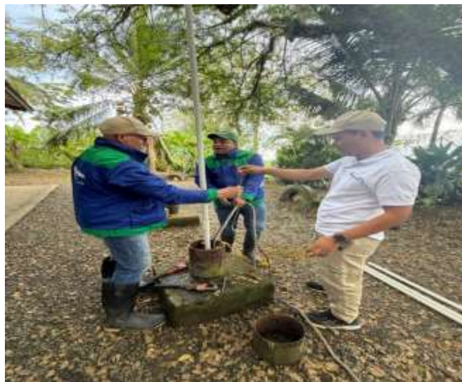
Registro fotográfico medición de Niveles en piezómetros y pozos productivos
