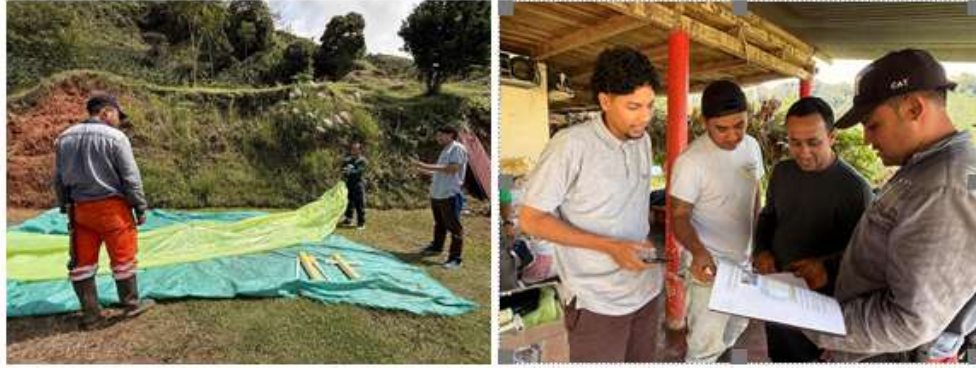
Proceso de entrega e instalación Biodigestores municipio de Abriaquí y frontino
