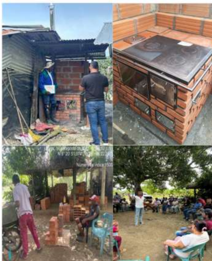
Proceso constructivo estufas eficientes; Suministro, construcción, y capacitación
