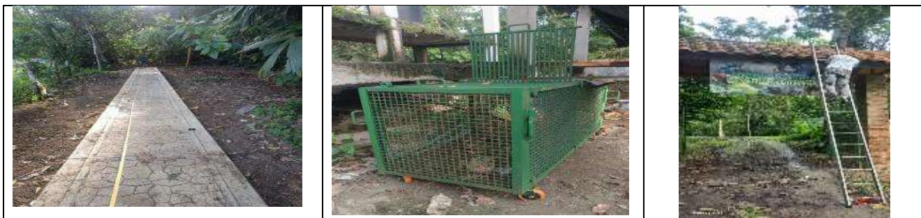
Puerta de acceso, Senderos peatonales, Escaleras peatonales, Reparación de jaulas.
