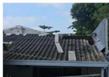
Desmonte y adecuación de lecho en teja eternit
