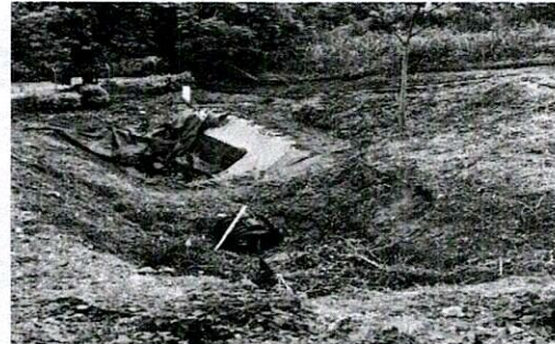
Imagen 4. Cunetas naturales de lixiviación
