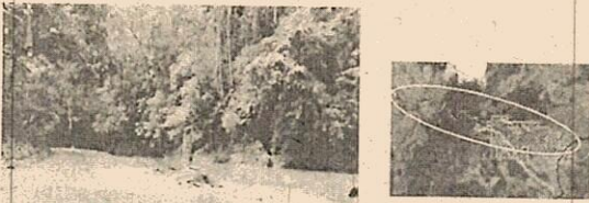
Figura 7. Acceso al área de explotación y construcción vía sobre el cauce del río
