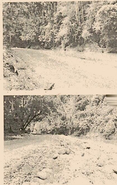
Figura 8. Acceso al área de explotación y construcción vía sobre el cauce del río
