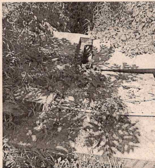
Fotografía 3. Caja de inspección
