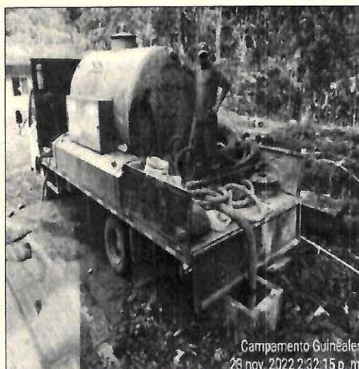
Imagen 3. Limpieza del pozo séptico.
