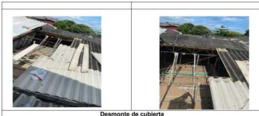
Se realizó cambio y mantenimiento de la cubierta del techo con el fin de mitigar dichas inundaciones o goteras ocasionados por las fuertes lluvias de la zona.
