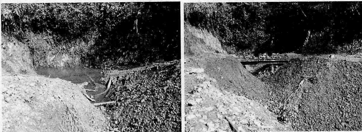
Fig. 5 y 6. Obstaculización y taponamiento de la quebrada El Diablo.
