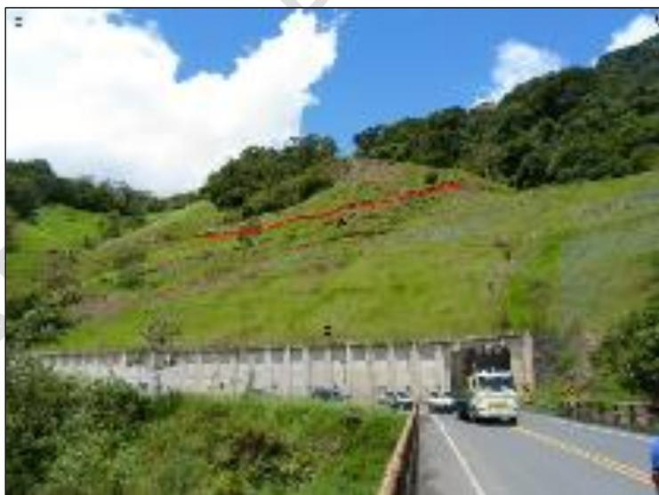
Figura 48. Deslizamiento rotacional estabilizado sobre la vía Dabeiba-Mutatá, en los cuales se observa la magnitud del mismo. Estación GJAM-23, cuyas coordenadas son: N 1267077, E 1087173.
