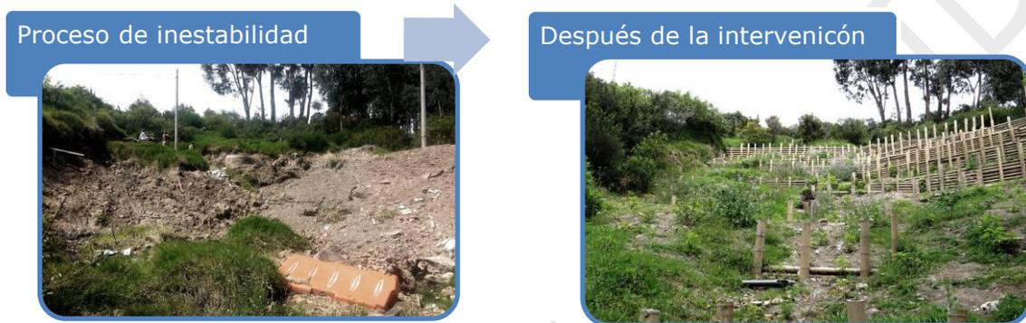
Figura 21. Ladera estabilizada con bioingeniería. Fuente: Foto Perico, N (2016)
