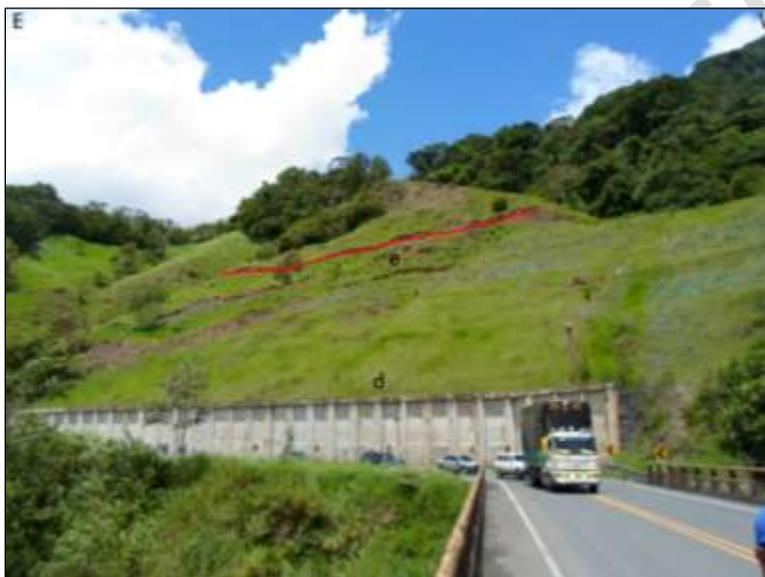
Figura 15. Deslizamiento rotacional estabilizado sobre la vía Dabeiba-Mutatá, en los cuales se observa la magnitud del mismo. Estación GJAM-23, cuyas coordenadas son: N 1267077, E 1087173. Elaboración propia.
