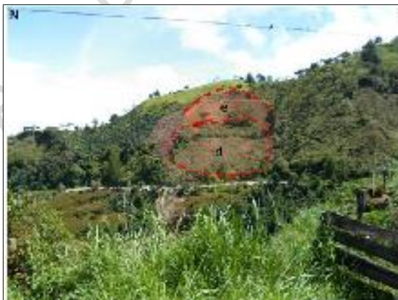
Figura 56. Deslizamiento de tipo rotacional en la cuenca alta del río Cañasgordas, donde se evidencia el escarpe
