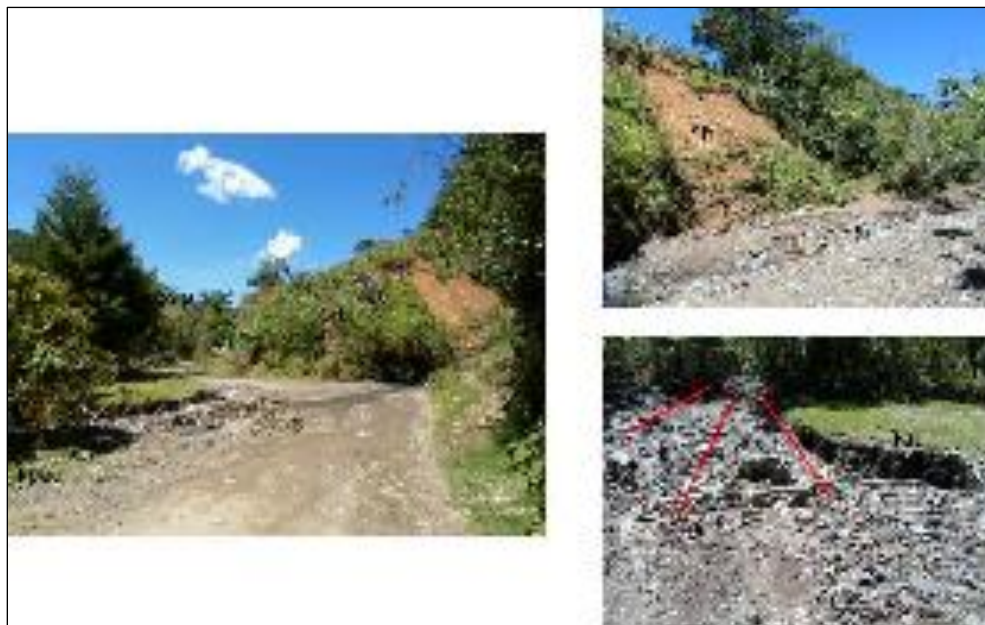
Figura 64. Flujos de lodo y tierra (DIFI) sobre la vía Abriaquí-Corcovado. Estación GJAM-37, cuyas coordenadas son: N 1265800, E 1114838.
