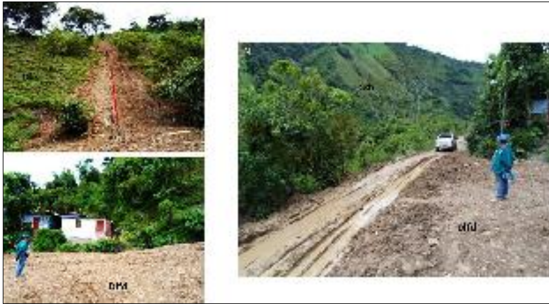
Figura 59. Flujos de detritos sobre la vía San José de Urama-Camparrusia. Estación GJAM-46, cuyas coordenadas son: N 1266055, E 1115105.
