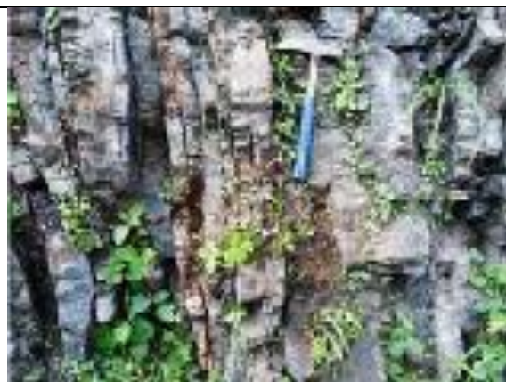
Figura 87. Macizo rocoso de los Chert y calizas de Nutibara (K2cn), con pocas discontinuidades espaciadas ampliamente, estación JAM-05, vía Nacional Medellín – Turbo, municipio de Cañasgordas, vereda Botija Bajo, coordenadas (1106263.6 E - 1247864.6 N).
