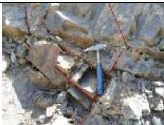
Figura 86. Discontinuidades presentes en el macizo rocoso de las litoarenitas, limolitas y lodolitas de Urrao (K2alu), sin alterar, bien entrabadas, bloques formados por tres familias de discontinuidades intersectadas, estación JAM-03, vía Nacional Medellín – Turbo, municipio de Cañasgordas, vereda Cirigüan, coordenadas (1232728.4E - 1121853.7N)
