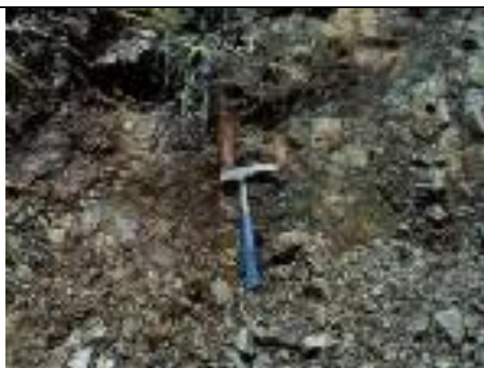
Figura 95. Macizo rocoso de los Basaltos de El Botón, muy fracturado,, con bloques pequeños angulosos formados por intersecciones de familias de discontinuidades, parcialmente alterado, estación JAM-28, vía Nacional Medellín – Turbo, municipio de Frontino, vereda El Llano, coordenadas (1092264.9E - 1242571.3N).
