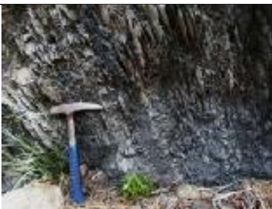
Figura 93. Macizo rocoso de las litoarenitas, limolitas y lodolitas de Urrao (K2alu), muy fracturado, plegado, con bloques pequeños angulosos formados por intersecciones de familias de discontinuidades, persistencia de esquistosidad, estación JAM-19, vía Nacional Medellín – Turbo, municipio de Dabeiba, vereda El Pital, coordenadas (1105758.5E - 1248007.7N).
