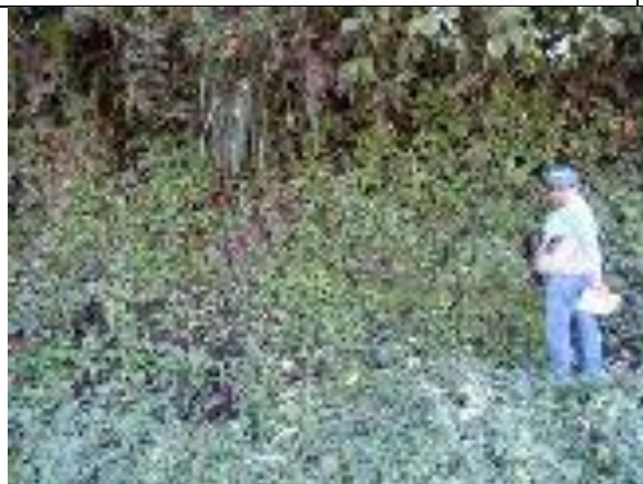
Figura 15. Zona de contacto de las lodolitas y litoarenitas de la Formación Urrao (K2alu) con capas de calizas con intercalaciones de chert de la Formación Nutibara (K2cn), Estación JAM-09, vía Nacional Medellín – Turbo, municipio de Cañasgordas, vereda La Esperanza, coordenadas (1106696.4 E - 1247825.4 N). Elaboración propia.
