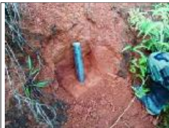
Figura 80. Toma de muestra inalterada de suelo residual arenolimoso de la unidad Srs2K2alu, estación JAM-23, vereda Pernilla, municipio de Cañasgordas, vereda Pernilla, coordenadas (1112262E - 1241980.5N).
