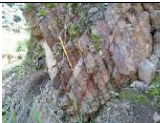
Figura 90. Macizo rocoso de los Chert y calizas de Nutibara (K2cn), estación JAM-09 C2, vía Nacional Medellín - Turbo, municipio de Cañasgordas, vereda Botija Bajo, coordenadas (1106696.4E - 1247825.4N)
