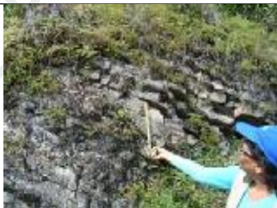
Figura 88. Macizo rocoso de los Chert y calizas de Nutibara (K2cn), con pocas discontinuidades espaciadas ampliamente, también se observa los planos de estratificación, estación JAM-05, vía Nacional Medellín – Turbo, municipio de Cañasgordas, vereda Botija Bajo, coordenadas (1106263.6 E - 1247864.6 N)
