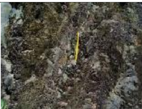
Figura 91. Macizo rocoso de los Chert y calizas de Nutibara (K2cn), muy fracturado, superficie pobremente entrabado, desintegrada, estación JAM-10 C2, vía Nacional Medellín - Turbo, municipio de Cañasgordas, vereda Botija Bajo, coordenadas (1105758.5E - 1248007.7N). Zona de enjambre de fallas.
