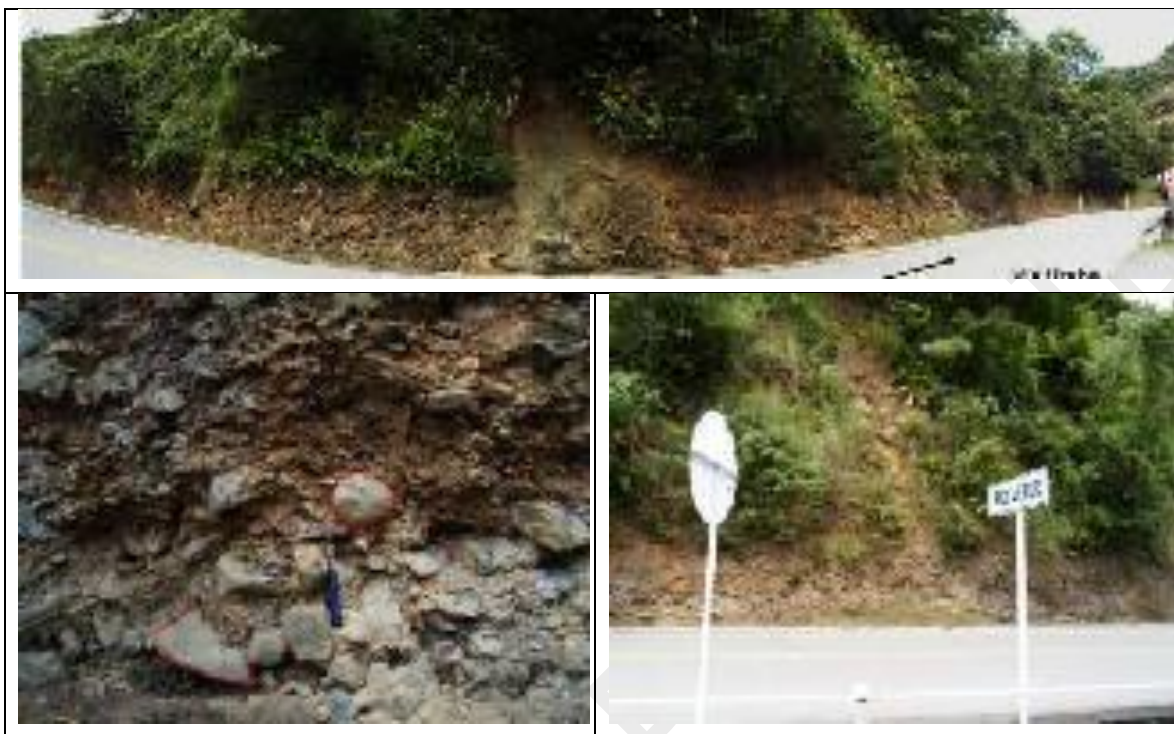
Figura 124. Panorámica Estación JAM-02 sobre la vía Dabeiba-Mutatá (Antioquía), donde se aprecia el corte sobre materiales de origen aluviales de hasta 8 m de altura con buena estabilidad.
