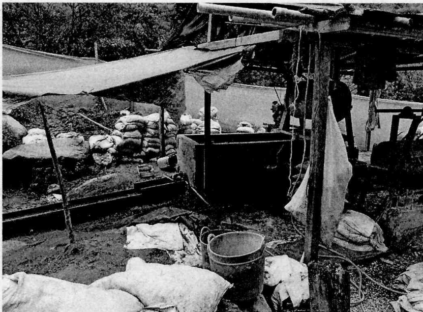
Nótese la infraestructura compuesta por tanques de sedimentación y canal de aprovechamiento y almacenamiento de material de mina en aproximadamente 30 sacos
