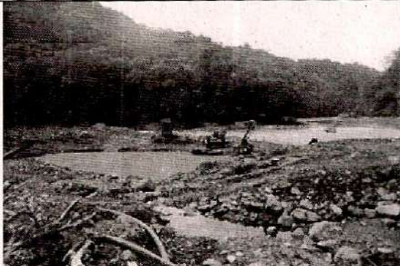
Piscina de socavación
