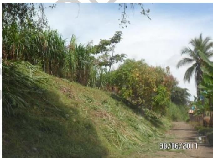
Figura 34. Dique para evitar inundación por el río Currulao en la vereda Puerto Cesar que cedió un mes después de tomada la foto.
