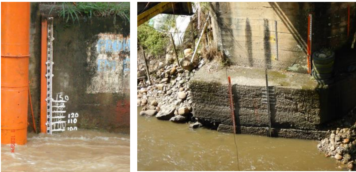
Figura 55. Fijación de las miras. Derecha: Estación Puente reyes, río Guavio, Fuente: Área Operativa 11- IDEAM 2017.
