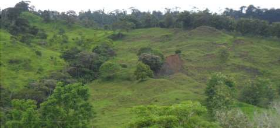
Figura 99. Deslizamientos Margen Izquierda río Guadualito, sector Alto de Mulatós – Quebrada El Volcán. Fuente: Elaboración propia.
