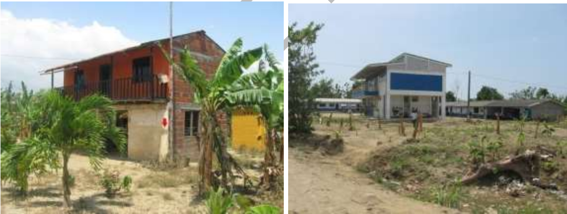
Figura 6. Detalles que indican la altura que alcanzaron las aguas del río Currulao y afectaron viviendas, la Institución Educativa Puerto César y cultivos.
