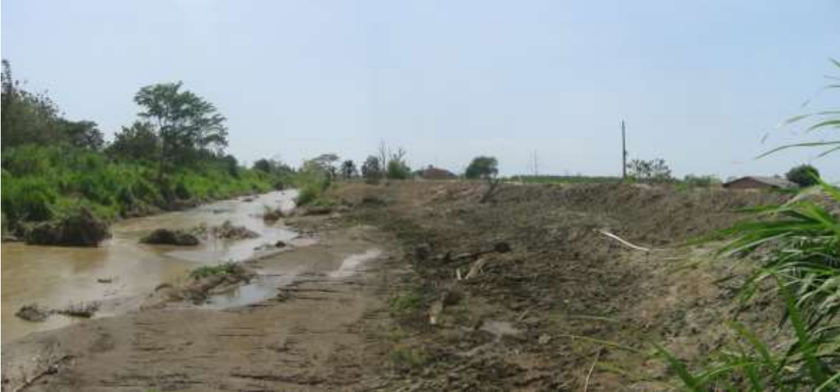
Figura 5. Sector de Puerto César Plátano donde el río Currulao rompió el dique de protección y destruyó 32 viviendas que estaban en la margen derecha del río.
