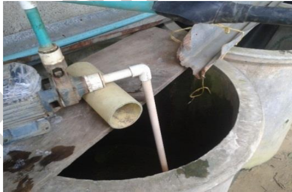
Figura 5. Sistemas de recolección y almacenamiento de aguas lluvias en las viviendas en el Corregimiento El Dos.
