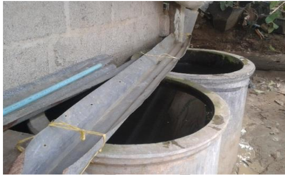
Figura 4. Sistema de recolección y almacenamiento de aguas lluvias en las viviendas en el Corregimiento El Dos.
