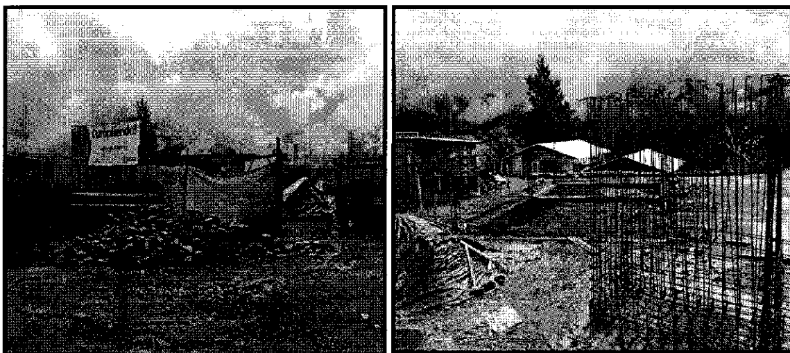
Figura 1. Nueva IE en proceso de construcción
