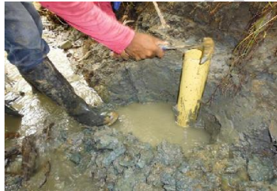
Figura 96. EG-20 Margen izquierda quebrada afluente de la quebrada Los Indios. Toma de muestra inalterada en tubo PVC de 3" de lodolita meteorizada (1044209E - 1392712N). Fuente: Elaboración propia.
