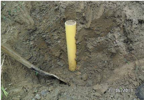
Figura 95. EG-09A sobre suelos residuales de arcillas muy saturadas de hasta 4m de espesor. Toma de muestra inalterada en tubo PVC de 3" (1063411E - 1375820N) Fuente: Elaboración propia.
